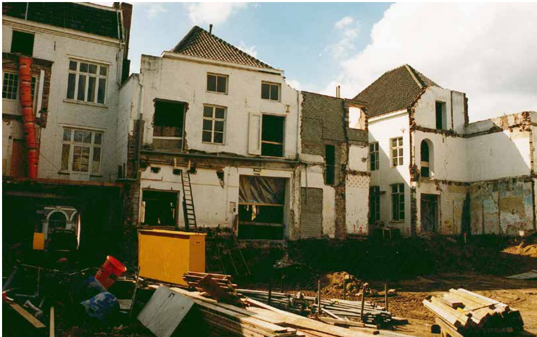
Voor de nieuwe bibliotheek werd het pand De Gouden Leeuw danig onder handen genomen. Aan de achterzijde verrees nieuwbouw. Collectie OB. Foto: Rob Kitslaar.
